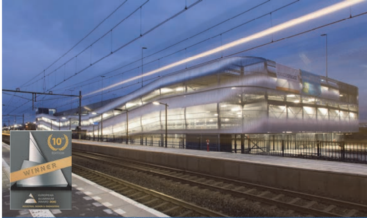
Gevel P&R treinstation Elst
